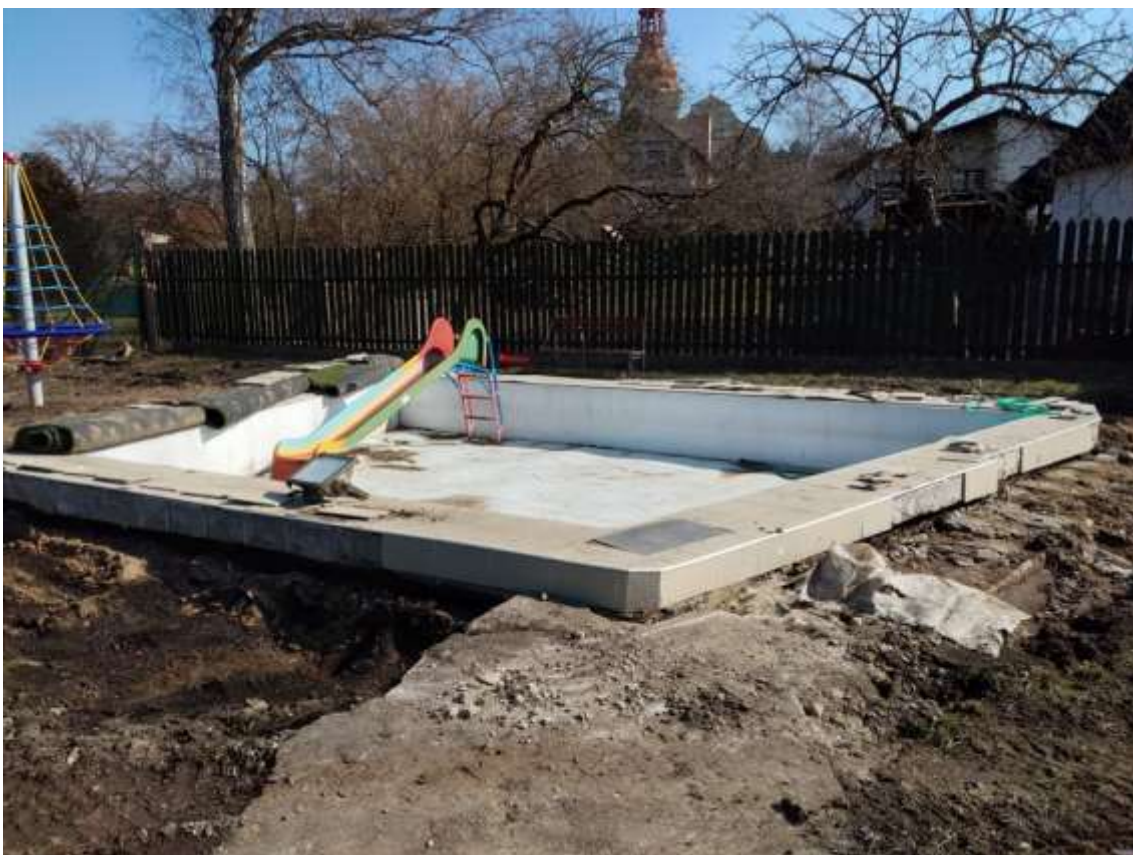
Obrázek 4 – Stavební a zemní práce na dětském bazénku
