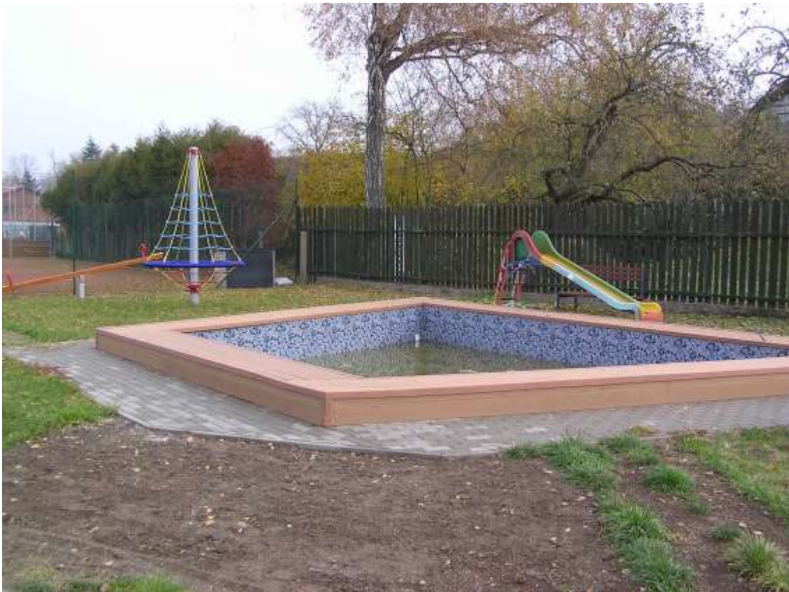
Obrázek 7 – Dokončená oprava dětského bazénku – potažení fólií, nový okraj s imitací dřeva, zámková dlažba a upravený trávník
