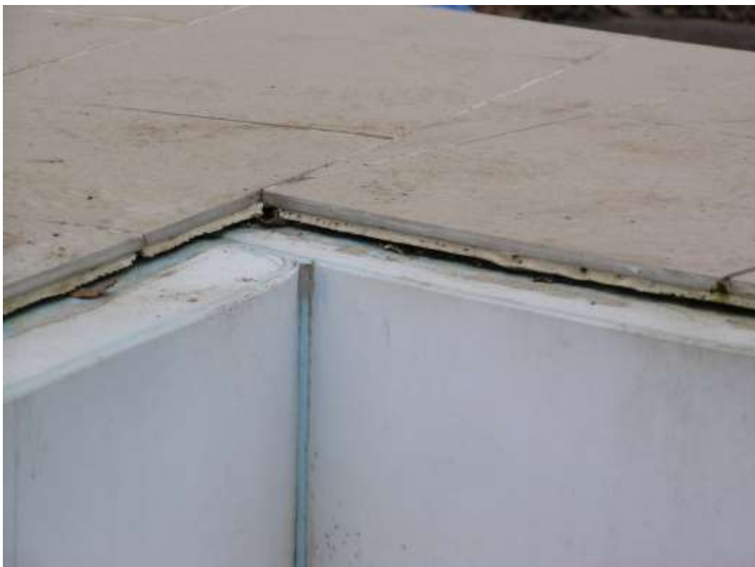
Obrázek 2 – Rozpadající se okraj dětského bazénku
