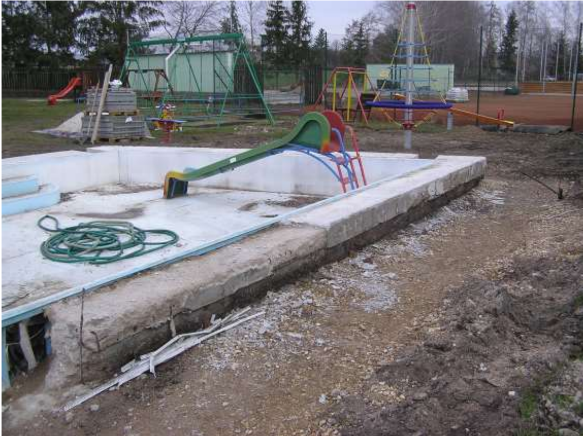
Obrázek 5 – Stavební a zemní práce na sanaci konstrukce dětského bazénku – příprava zdláždění okolo bazénku
