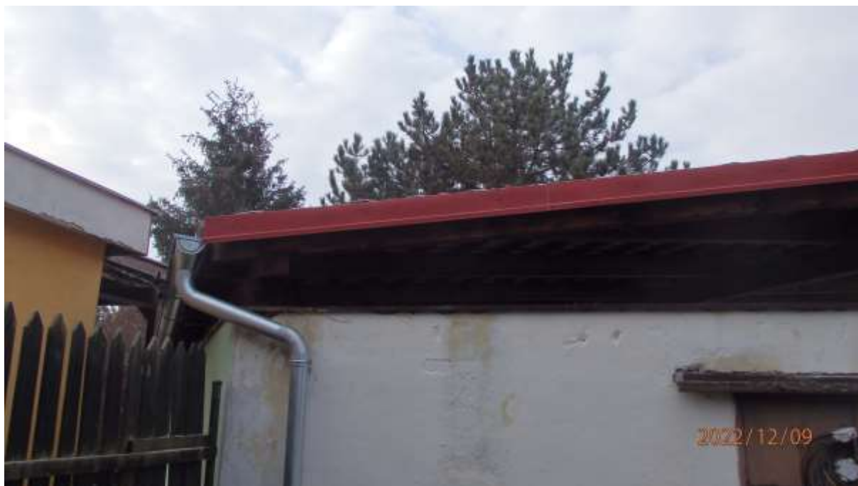
Obrázek 11 – Opravená střecha pódia „Dupanda“ – nové klempířské konstrukce
