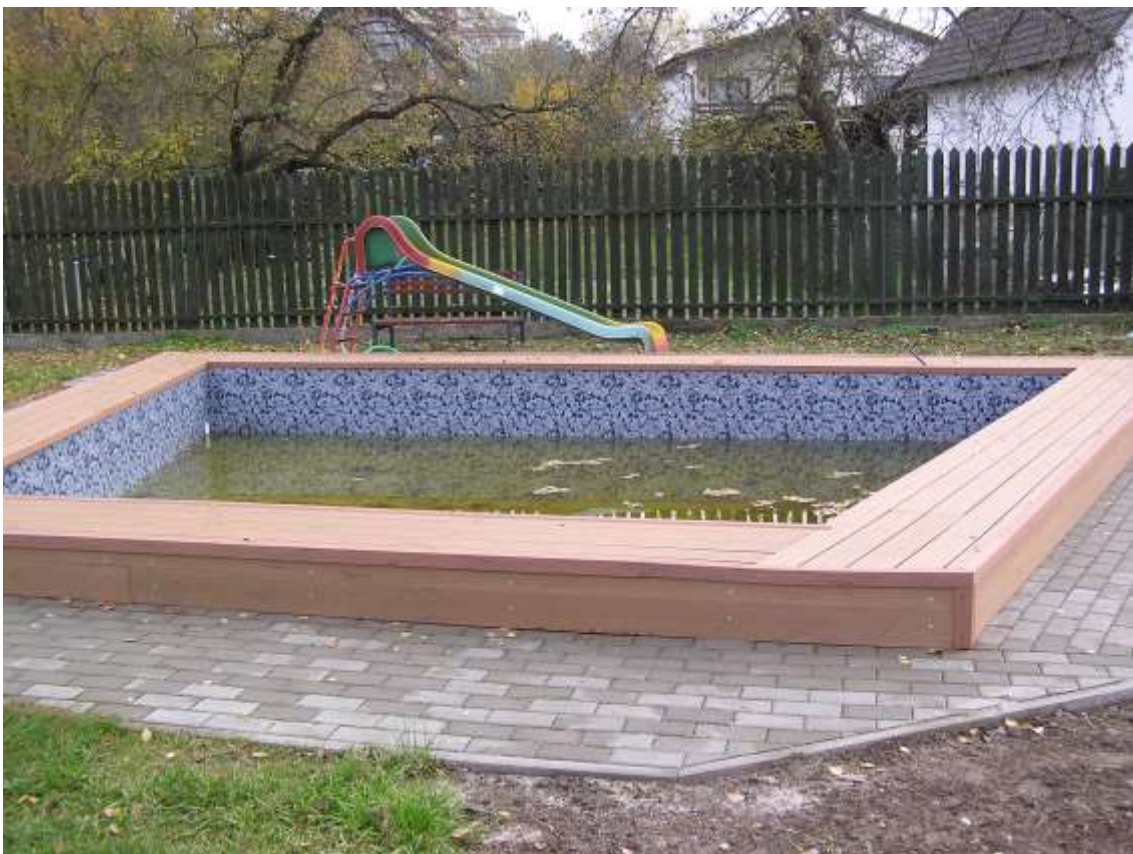
Obrázek 8 – Dokončená oprava dětského bazénku
