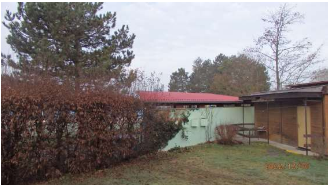
Obrázek 10 – Opravená střecha pódia „Dupanda“
