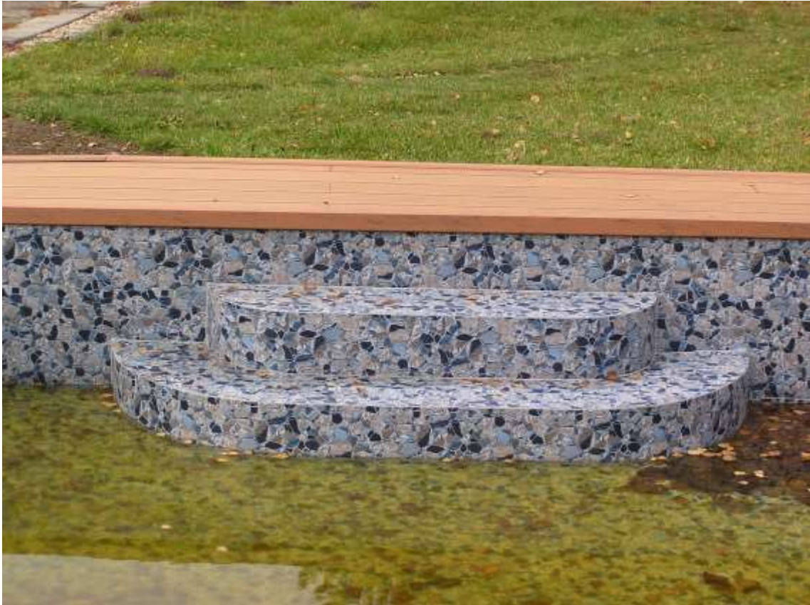
Obrázek 9 – Opravené schůdky do dětského bazénku
